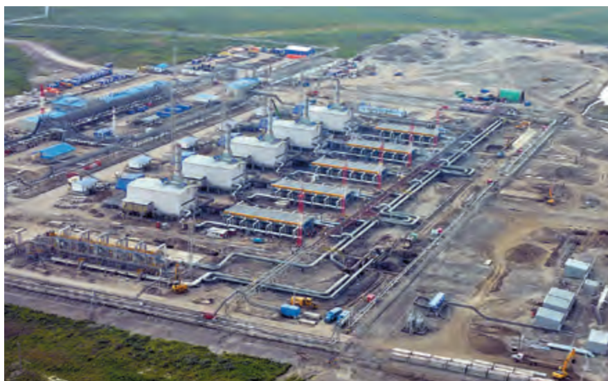
Компрессорная станция Сынинская магистрального газопровода Бованенково – Ухта. Антикоррозионная защита оборудования, трубопроводов, опорных металлоконструкций: ЦИНОТАН + ПОЛИТОН-УР + ПОЛИТОН-УР(УФ) Огнезащита несущих металлоконструкций: ПЛАМКОР-2
