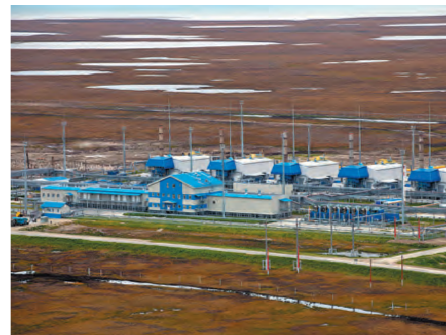
Главная компрессорная станция Байдарацкая магистрального газопровода Бованенково – Ухта. Антикоррозионная защита оборудования, трубопроводов, опорных металлоконструкций: ЦИНОТАН + ПОЛИТОН-УР + ПОЛИТОН-УР(УФ)
